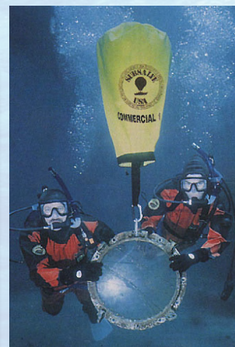
Industrie Hebesack beim Einbau eines "Mannloches"
